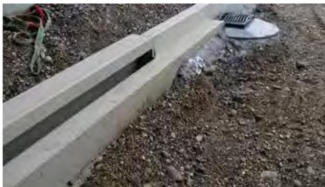
Esempio di raccordo tra cordolo e canale a fessura, entrambi in calcestruzzo polimerico.
