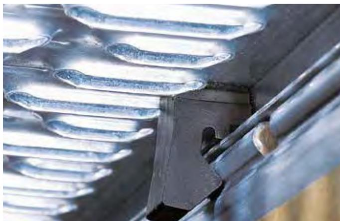
Grazie al sistema Drainlock®, non sono più necessarie barrette trasversali per il fissaggio delle griglie.
