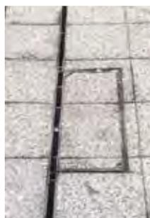
La copertura dell'elemento di ispezione, posizionato sopra il pozzetto di scarico, può essere facilmente sollevata tramite gli appositi ganci ACO (cod. art. 16364) in modo da estrarre e svuotare il secchio raccoglifanghi. L'interno della fessura può essere pulito efficacemente con un pulitore ad alta pressione.
