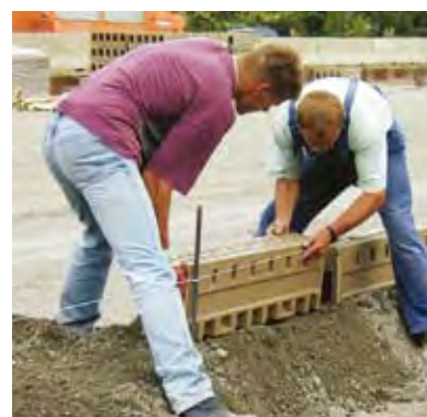
Costruzione di una linea di drenaggio autostradale con Monoblock
