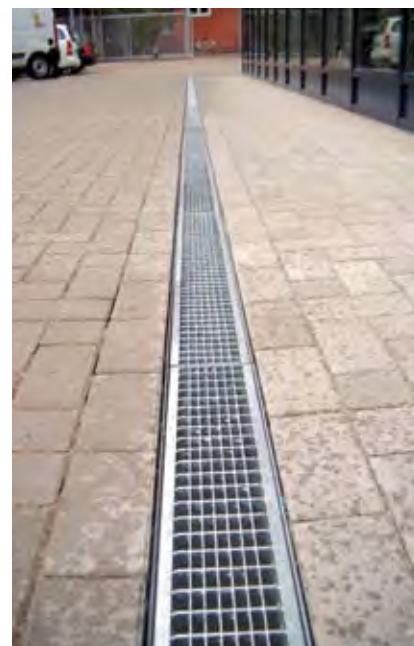
Canalizzazione con grigliato a maglie in acciaio zincato su piazzale di centro logistico.
