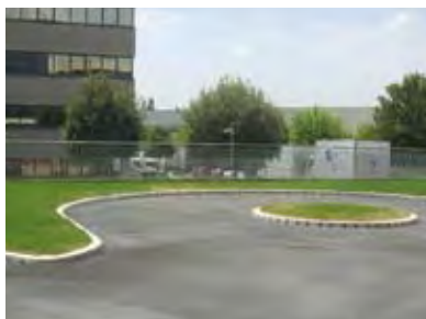
Centro Tecnopolo Tiburtino, Roma - Drenaggio piazzale con Kerbdrain
