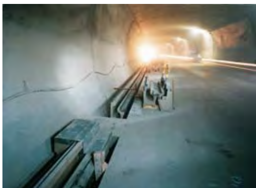
Fase di posa di canali Aco Tunnel
