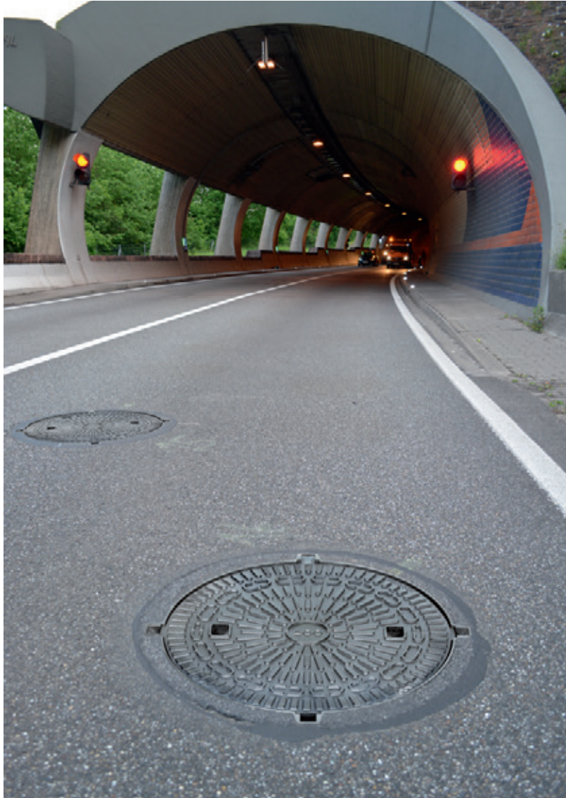
Neue Schachtabdeckungen in der Fahrspur am Portal Barbarossatunnel: ACO Multitop
