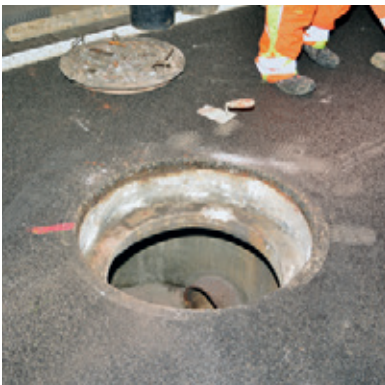
Die alte Abdeckung wurde entfernt und der Schacht wurde für den Einsatz der neuen ACO Schachtabdeckung Multitop vorbereitet
