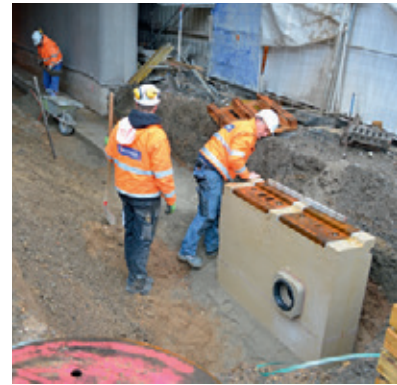
Versetzen des Tauchwandschachts am Strangende
