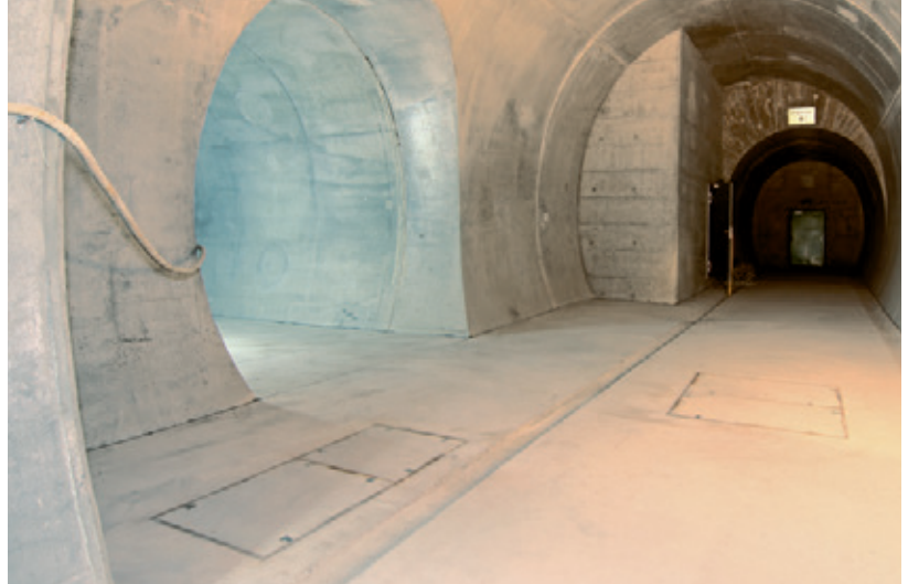
ACO Schachtabdeckungen Secant im Wattkopftunnel als Revisionsabdeckung
