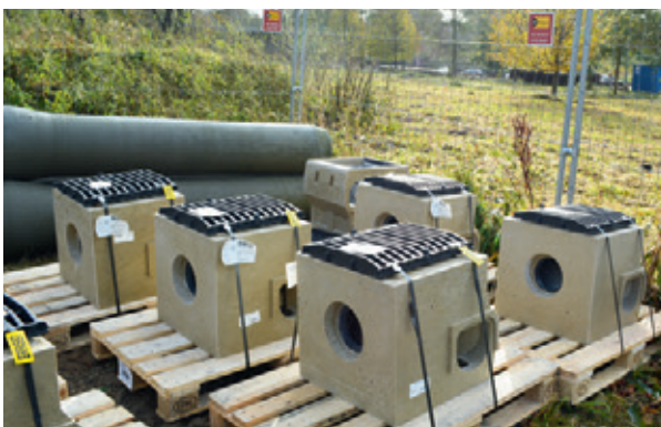
Tauchwandschächte bereit zum Einbau
