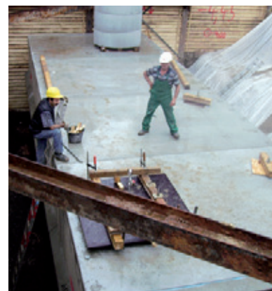
Einbaubeispiel: Löschwasserbehälter 100.000 l, Universität Mainz
