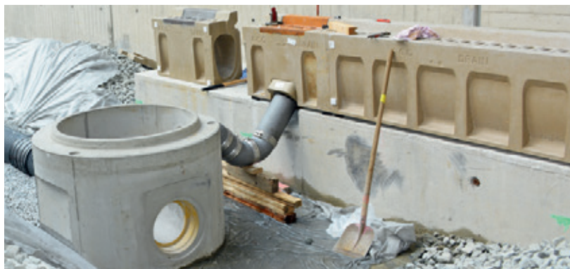
Anschlusselement mit Rohrsiphon zum Revisionsschacht und Anschluss an die Längsentwässerungsleitung
