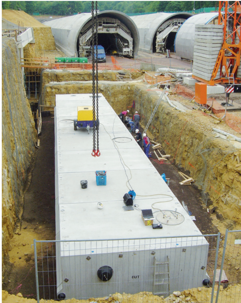
ACO Großbehälter als Havariebecken mit Feuerlöschbehälter am Stafelter Tunnel
