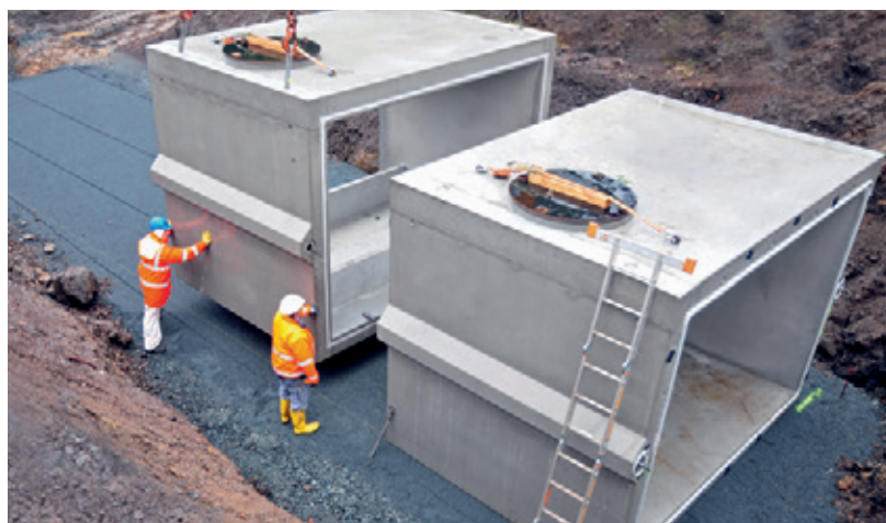
Die Verbindung der ACO Großbehälter untereinander erfolgt über einen Spannstahl
