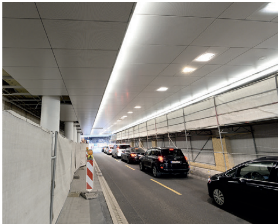
Neu gestalteter Tunnel mit verlegter Tunnelrinne und fertiger Fahrbahndecke, Foto: Udo Gottschalk, Express
