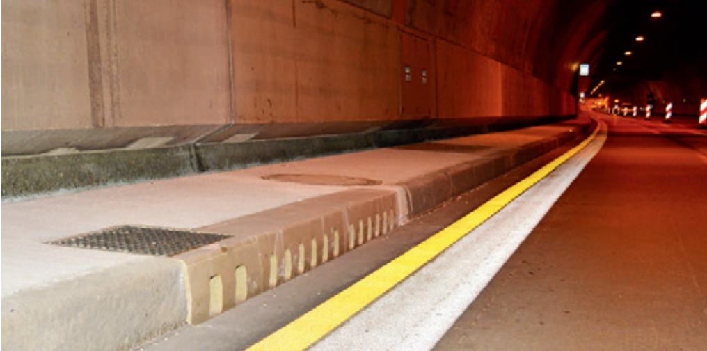
ACO Tauchwandschacht im Tunnel Pfaffenstein
