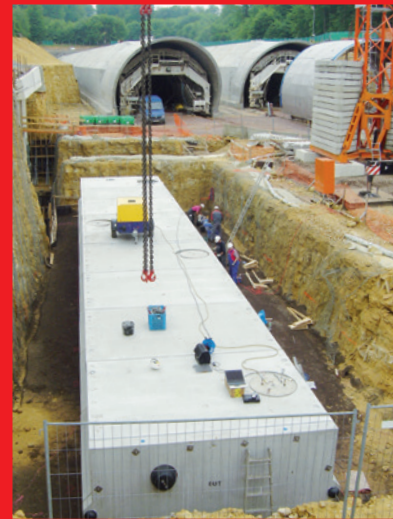
ACO Großbehälter als Havariebecken
