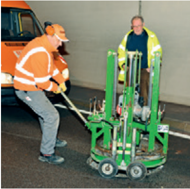
Ziehen des alten Rahmens der Schachtabdeckung
