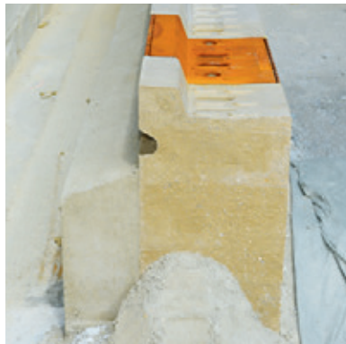
Tunnelrinne und fahrbahnseitig abgestochenes Fundament mit einseitiger Rückenstütze
