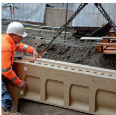
Fachgerechtes Setzen der Tunnelrinnen
