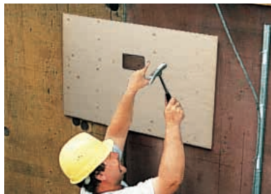
3. Stützplatte auf der Schalung befestigen.
