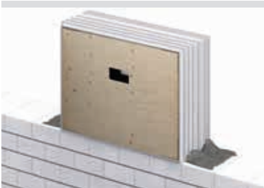
1. Fenster satt in Mörtel setzen.
