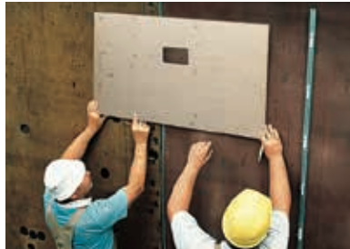
2. Stützplatte waagrecht fixieren.
