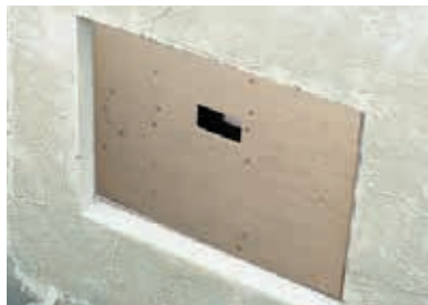
5. Die äußere und die innere Stützplatte verbleiben bis zum Abschluss der Rohbauphase zum Schutz vor Beschädigungen in dem Leibungsfenster.
