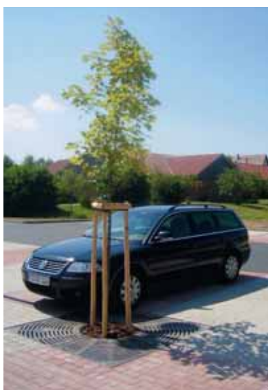
Dem Nutzungsdruck widerstehen: Baumschutzroste schützen den Wurzelbereich in Stellplatzbereichen und bieten zusätzlichen Parkraum
