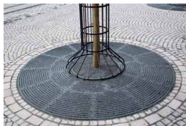
Hamburg, Jungfernstieg: WOTAN Baumschutzroste werden während des Auf- und Abbaus für Veranstaltungen durch mobile Absperrpoller ergänzt
