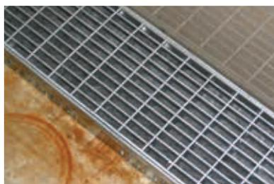
Ein eingelegtes Schmutzvlies reduziert bereits im saubereren Zustand die hydraulische Leistung des Systems um 30%
