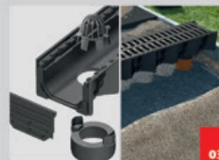
Coloque as canaletas com a tampa lateral e as grelhas sobre a base de concreto, iniciando pela tubulação de saída. Proteja a grelha para que não caia concreto sobre ela.
