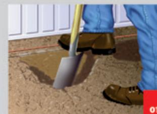
Escave a vala onde a linha de drenagem será instalada e faça uma base de concreto de, pelo menos, 5cm. Nivele a base.
