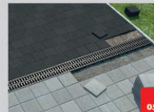
Preencha as laterais com concreto e faça o acabamento com o piso em volta. Ele deve ficar, no mínimo, 3mm acima do nível da grelha.
