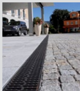
C250 (3) Carga de ensaio 250 kN - 25t. Laterais de vias e áreas não trafegadas de acostamento ou similares.
