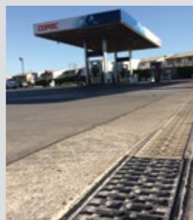
D400 (4) Carga de ensaio 400 kN - 40t. Faixas de rolamento de rodovias (incluindo vias urbanas), acostamentos e áreas de estacionamento para todos os tipos de veículos de rodagem.
