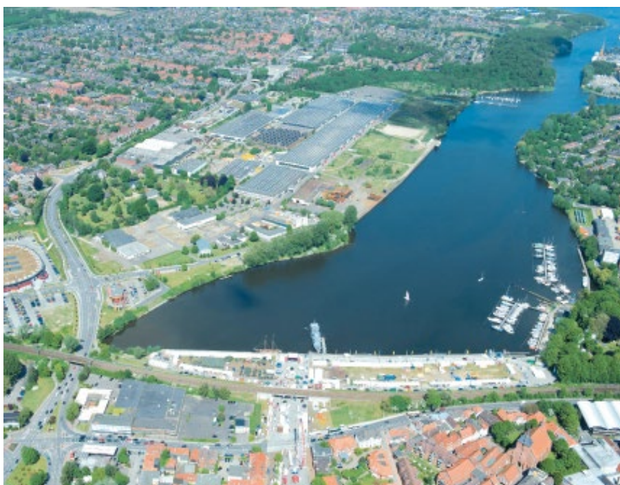
Sede do Grupo ACO em Rendsburg/Büdelsdorf - Alemanha
